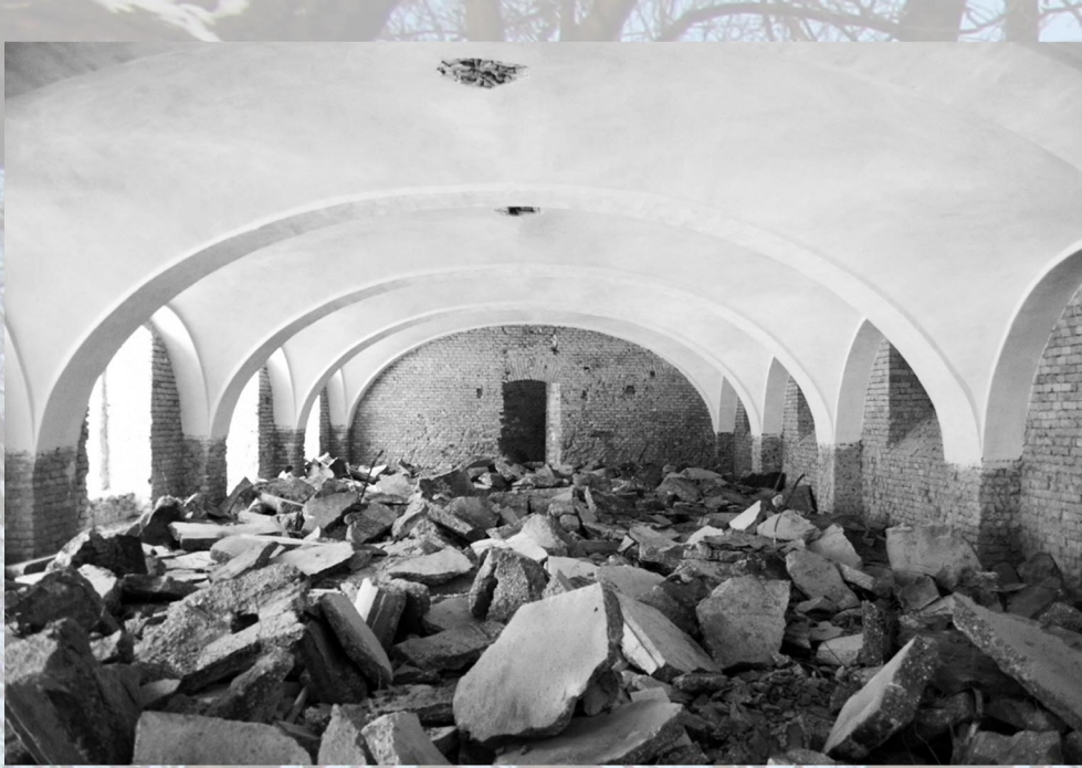
Die ehemaligen Stallungen werden aufwändig renoviert. Hier werden bald Schuhe gefertigt.
