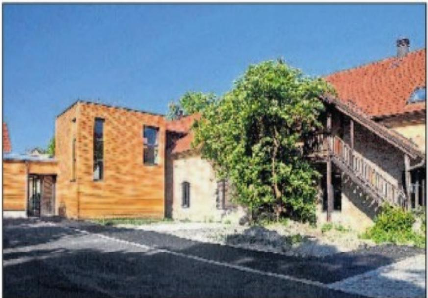
Das alte Ambiente wurde, wo es ging, beibehalten. Ein neuer Zubau in Holzleichtbauweise dient als Lager und Verbindungsgang.
